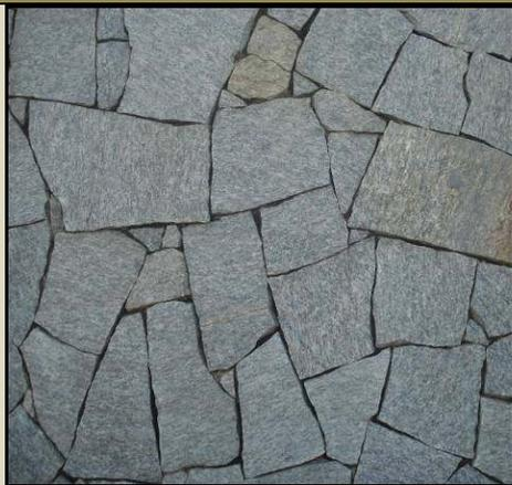
Figura 3.15 – Detalhe do painel revestido com placas irregulares de quartzito na Praça das Mães (Fonte: Marcos Nascimento).
