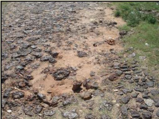
Figura 4.104 – Detalhe de um trecho no qual as pedras originais foram removidas (Fonte: Marcos Nascimento).
