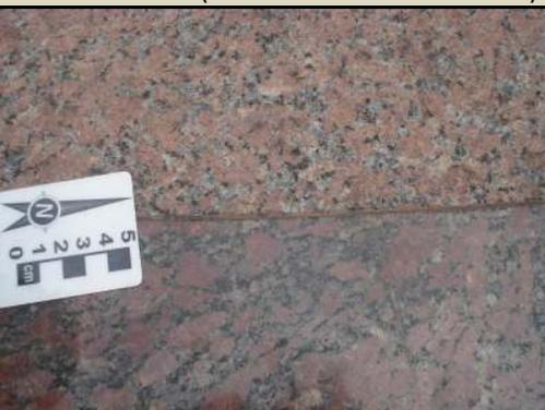
Figura 4.60 – Detalhe das diferentes texturas (polida e apicoada) aplicadas nas placas da rocha porfirítica da intervenção mais recente (Fonte: Marcos Nascimento).
