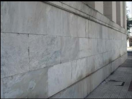
Figura 4.132 – Base fachada revestida com a barra de mármore (Fonte: Marcos Nascimento).
