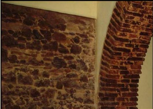
Figura 4.144 – Detalhe alvenaria de pedra, composta pelos blocos de *beachrocks* e do arenito ferruginoso da Formação Barreiras (Fonte: Acervo IPHAN/RN).
