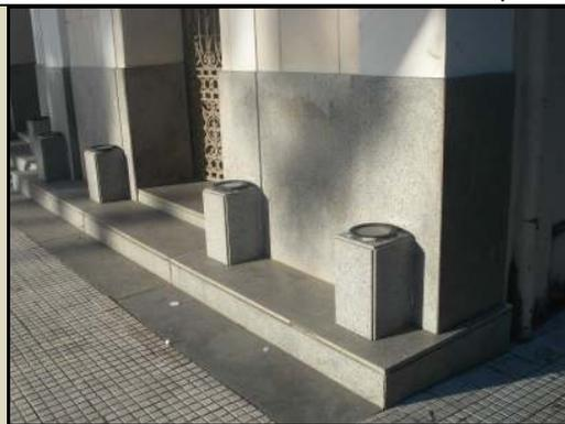
Figura 4.120 – Base fachada revestida com as placas de granito (Fonte: Marcos Nascimento).
