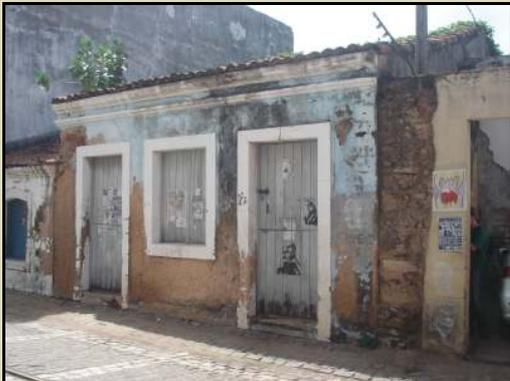
Figura 4.145 – Casa colonial onde a alvenaria está exposta (Fonte: Marcos Nascimento).
