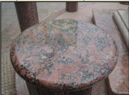
Figura 4.59 – Detalhe da rocha granítica de textura porfirítica que reveste os pilares colocados em uma intervenção mais recente (Fonte: Marcos Nascimento).
