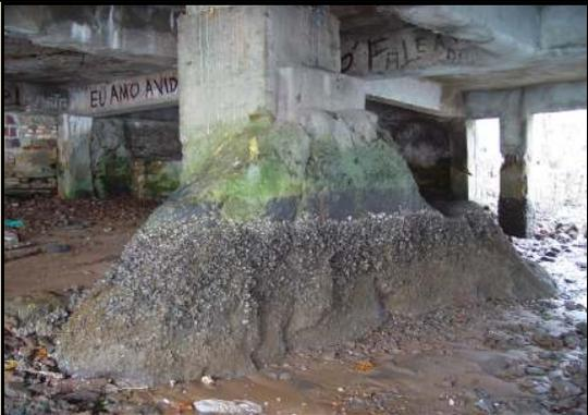
Figura 4.80 – Bloco do arenito ferruginoso sob a plataforma de alvenaria - funciona como fundação para a coluna de alvenaria que sustenta a santa (Fonte: Acervo IPHAN/RN).
