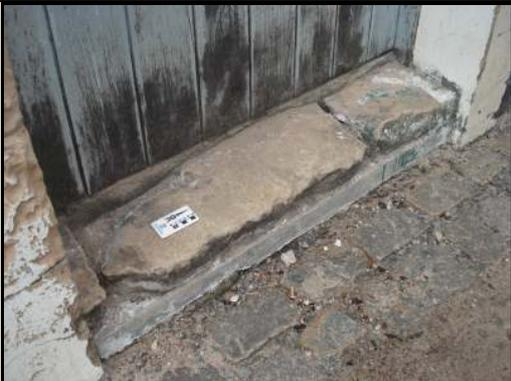
Figura 4.146 – Detalhe da soleira de pedra (arenito com cimentação carbonática) (Fonte: Marcos Nascimento).
