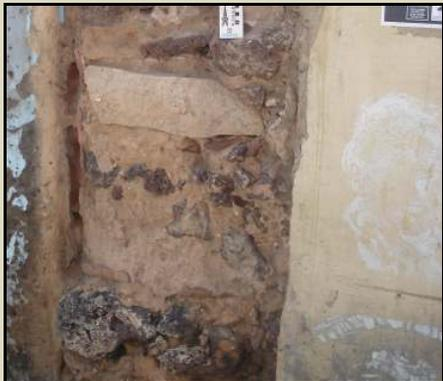
Figura 4.147 – Detalhe da alvenaria de pedra (arenitos de praia, arenitos ferruginosos, tijolos de adobe, etc.) (Fonte: Marcos Nascimento).
