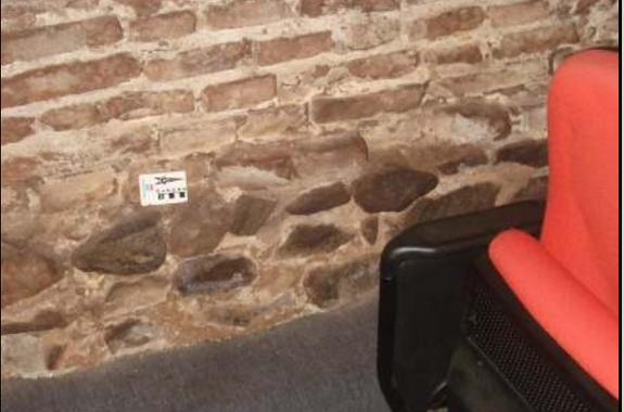
Figura 4.136 – Detalhe do sistema construtivo, fundação de pedra (arenito ferruginoso da Formação Barreiras) e alvenaria de tijolos de adobe (Fonte: Marcos Nascimento).
