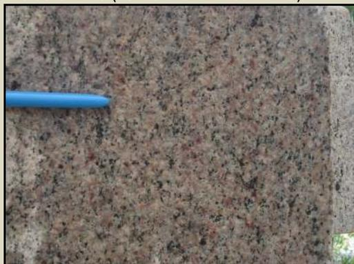
Figura 4.51 – Aspecto geral do granito utilizado na cantaria (Fonte: Marcos Nascimento).
