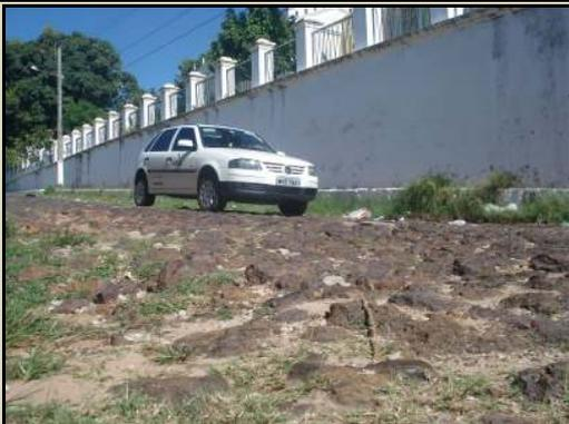
Figura 4.102 – Detalhe do tráfego de veículos, acelerando a degradação do calçamento (Fonte: Marcos Nascimento).
