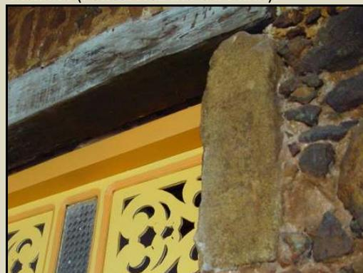
Figura 4.66 – Detalhe alvenaria de pedra, composta pelos blocos de *beachrocks* e do arenito ferruginoso da Formação Barreiras (Fonte: Heliana Carvalho).
