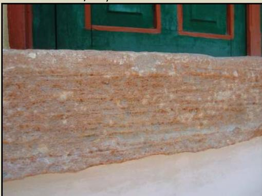
Figura 4.63 – Detalhe da estratificação plano-paralela do arenito utilizado na soleira de pedra da fachada (Fonte: Heliana Carvalho).
