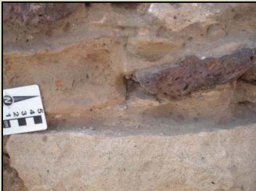
Figura 4.148 – Detalhe dos diversos materiais utilizados na alvenaria – tijolo de adobe, laterito e *beachrock* (Fonte: Marcos Nascimento).
