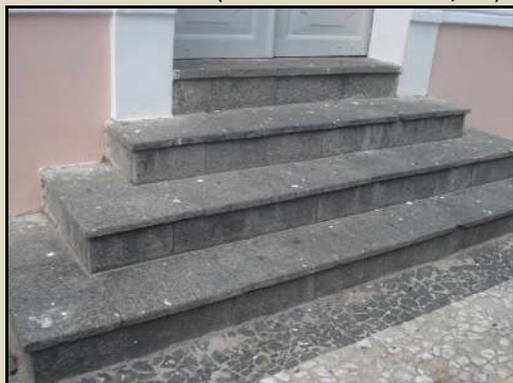
Figura 4.33 – Escadaria revestida com placas de ortognaisse (Fonte: Marcos Nascimento).
