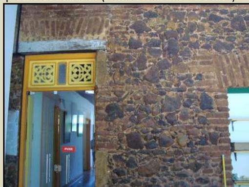
Figura 4.65 – Alvenaria de pedra, composta pelos blocos de *beachrocks* e do arenito ferruginoso da Formação Barreiras (Fonte: Heliana Carvalho).
