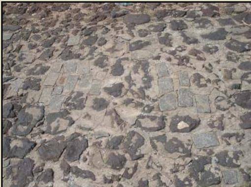
Figura 4.103 – Detalhe de um trecho onde o calçamento original foi substituído por outros tipos de rocha (Fonte: Marcos Nascimento)
