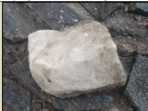
Figura 4.40 – Detalhe dos bloquetes de mármore que compõem o mosaico da calçada (Fonte: Marcos Nascimento).
